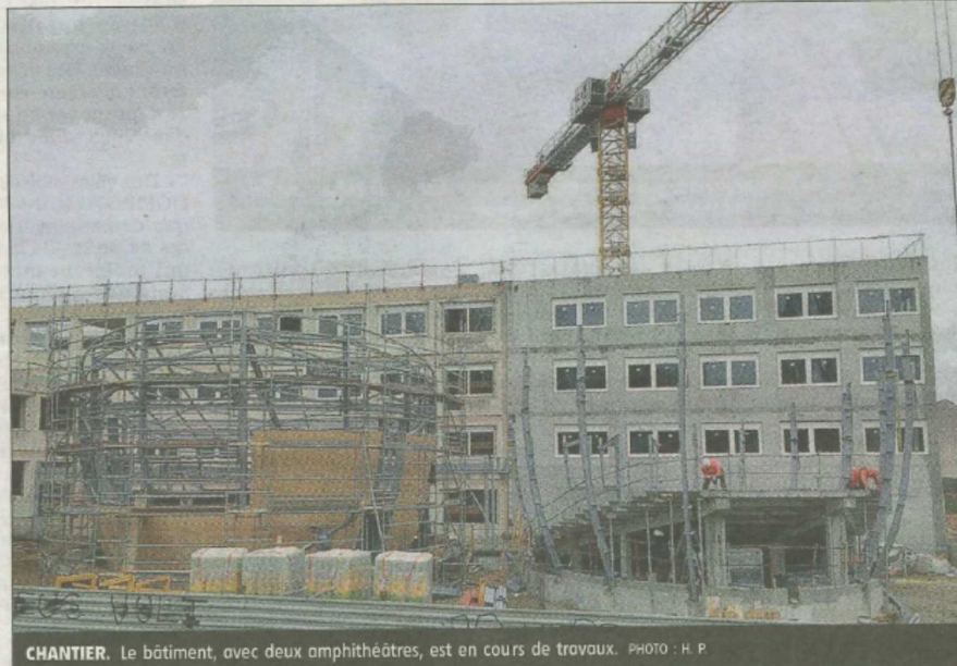
CHANTIER. Le bâtiment, avec deux amphithéâtres, est en cours de travaux. PHOTO : H. P.
